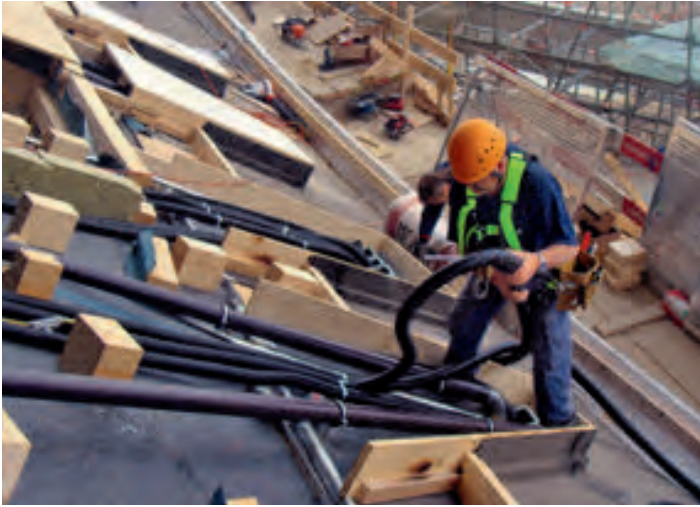
Installieren auf dem Elefantendach erfordert Kenntnisse in der Handhabung von Seil und Klettergurt.
