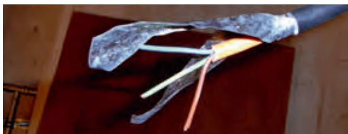
In Elefantennähe fühlen sich auch Nagetiere wohl. Da brauchen die Kabel eine Stahlband-Ummantelung, die nicht nur den Nagern das Nageln vermiest, sondern auch unseren Monteuren die Freude am Abisolieren nimmt.
