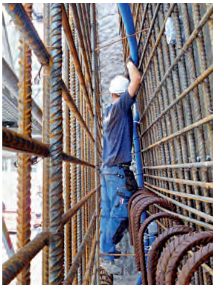
In der Vertikalen innerhalb der Elefantenarmierung sind nur schlanke Monteure fähig, Leerrohre einzubauen.
