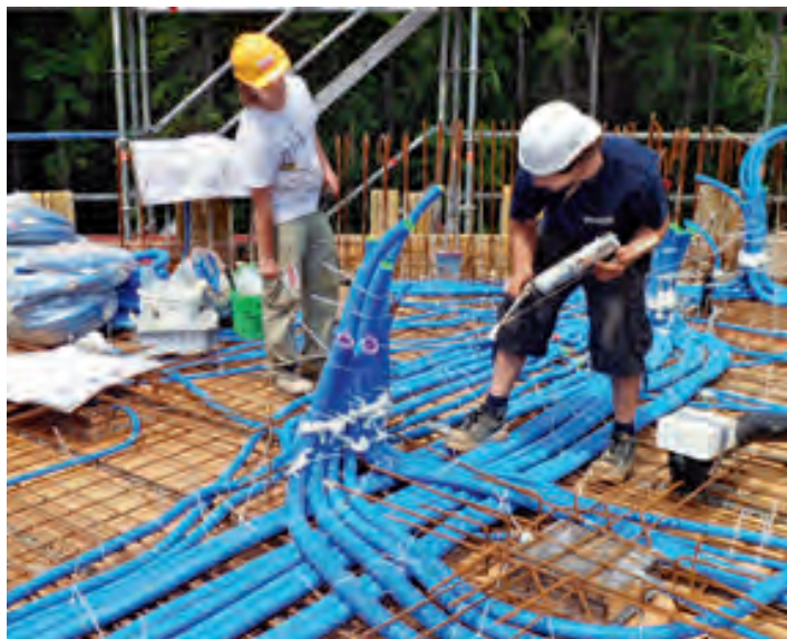
Auf der Horizontalen lassen sich Leerrohre bequem verlegen.
