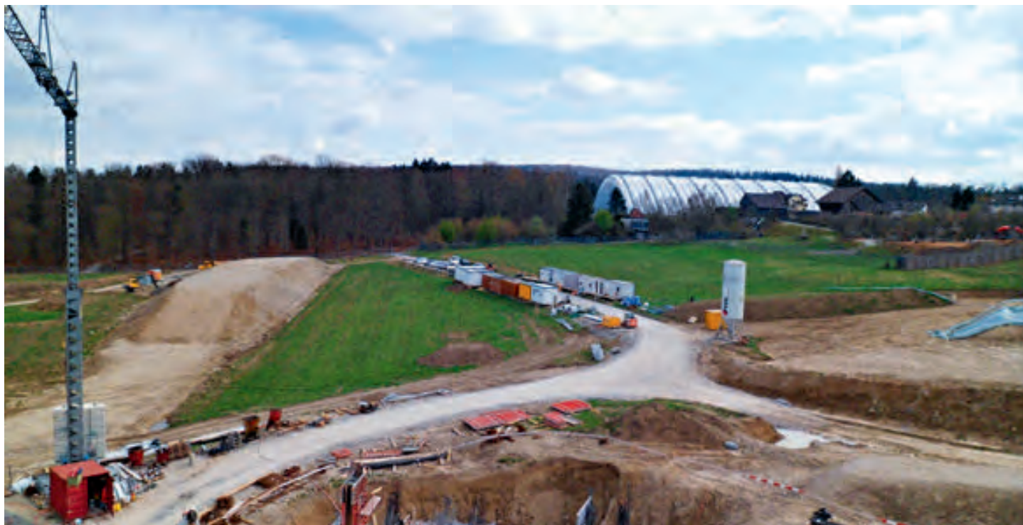
Es begann mit der Baugrube 2011. Im Hintergrund die Masoala-Halle.
