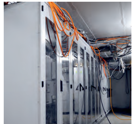
Die neue Hauptverteilung wurde im März in Betrieb genommen.
