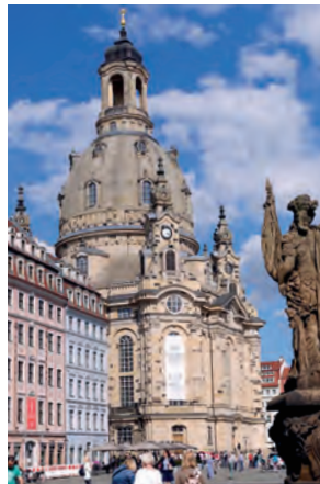
Teilinstallation: Frauenkirche - Technikanlagen und Unterkirche
