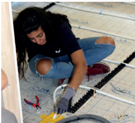
Auf der Baustelle werden alle Hände gebraucht. Auch solche, die bisher mit Strom nicht viel zu tun hatten. Bild: Aybüke Demirkol
