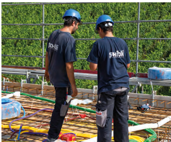
Installationskontrolle durch Beni Höhn und Dario Loureiro.
