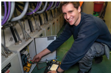
Riccardo Giovanoli unterstützt im Technikraum mit Messungen.
