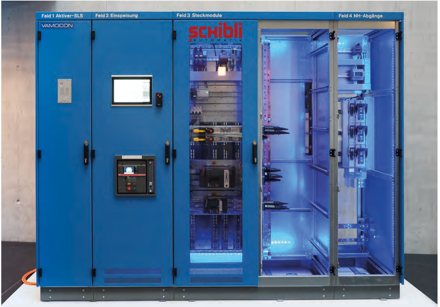
Die Vamocon-Muster-Schaltschrankanlage beinhaltet auch einen aktiven Störlichtbogen und kann für Messen oder Events zu Demozwecken genutzt werden.
