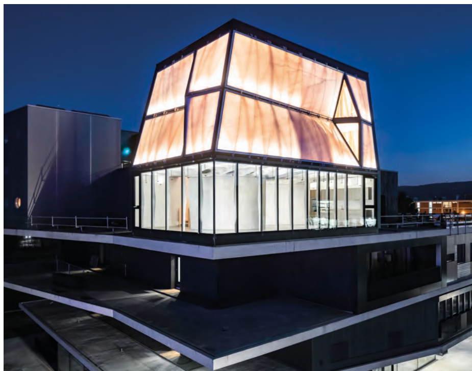
DFAB House und NEST leuchten in der Abenddämmerung. Foto: Roman Keller.
